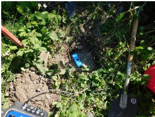
Bild 1. Placering av givare till mätpunkt 3, före jordtäckning.
